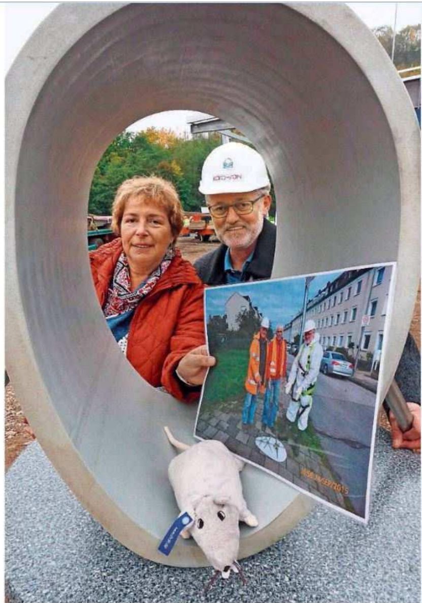
Rita Guthörl und Werner Zimmer von der Karo-san blicken durch ein Rohr im Ei-Profil. FOTO: WILLI HIEGEL
