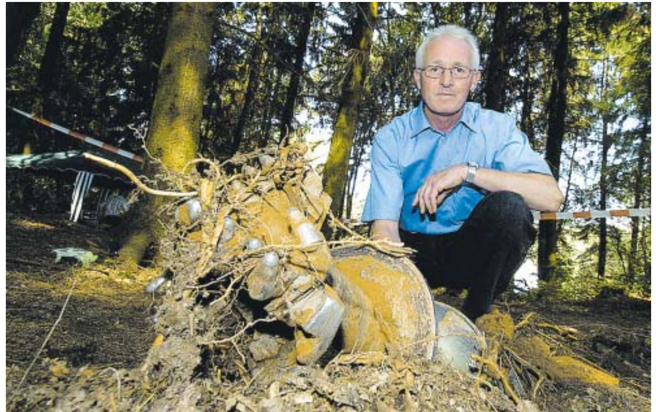
Der Bohrkopf dringt aus der Tiefe durch Gestein und Wurzeln an die Oberfläche. Es ist das letzte von 33 Löchern, die die Männer von Polier Siegfried Zimmer vom Basiskanal nach oben gebohrt haben. Foto: Rolf Ruppenthal
