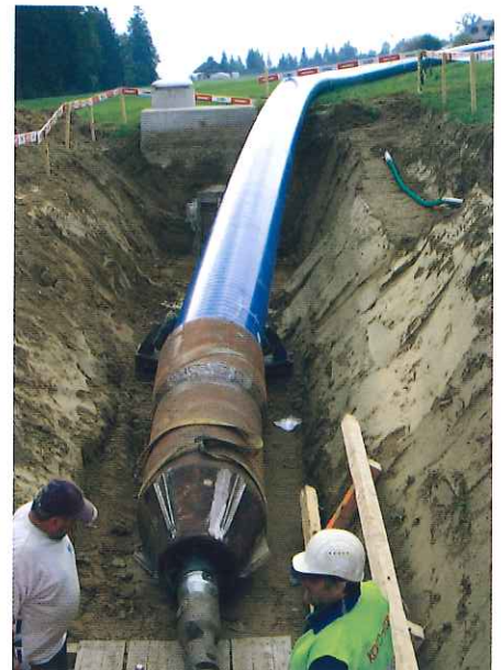
Burstlining-Verfahren: grabenlose Rohrerneuerung von 100 mm – 1000 mm Rohrdurchmesser bei bis zu 420 m Rohrlänge.
